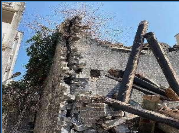
实地考察拆迁中的翠微村
